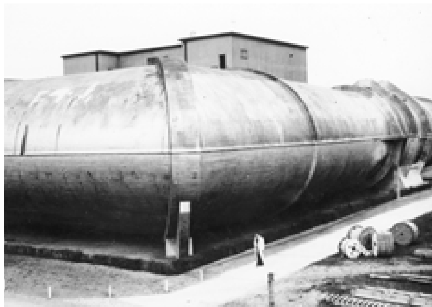
HET »GROTE WINDKANAAL« DAT IN DE JAREN '30 IN ADLERSHOF WERD GEBOUWD, IS NOG ALTIJD INTACT.
